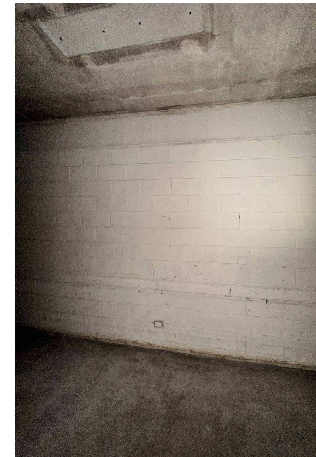
EXISTING INTERIOR CMU BLOCK (TYP.) 2 N.T.S
