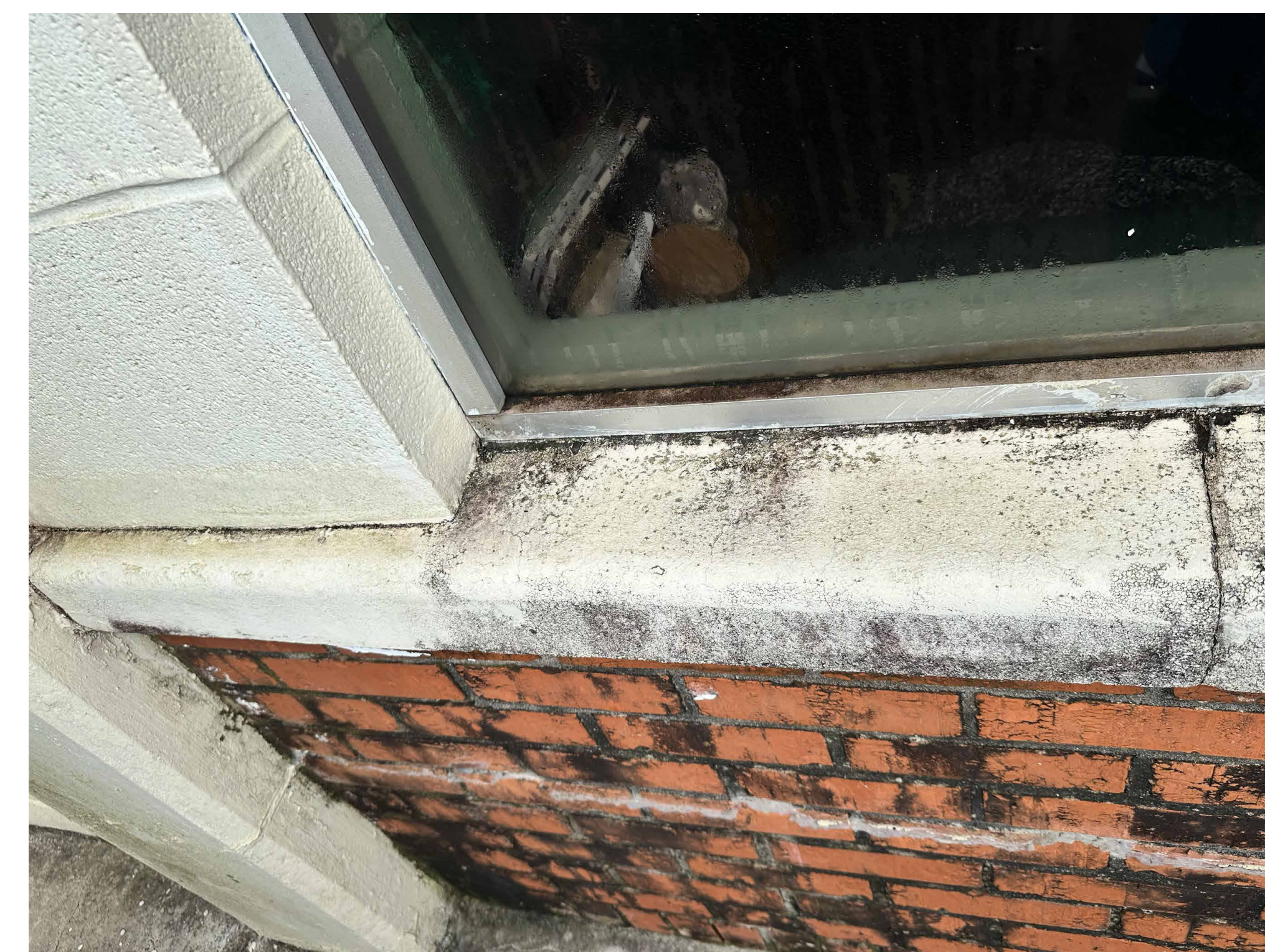
EXISTING BRICK LEDGE @ CMU (TYP.) N.T.S. 1
